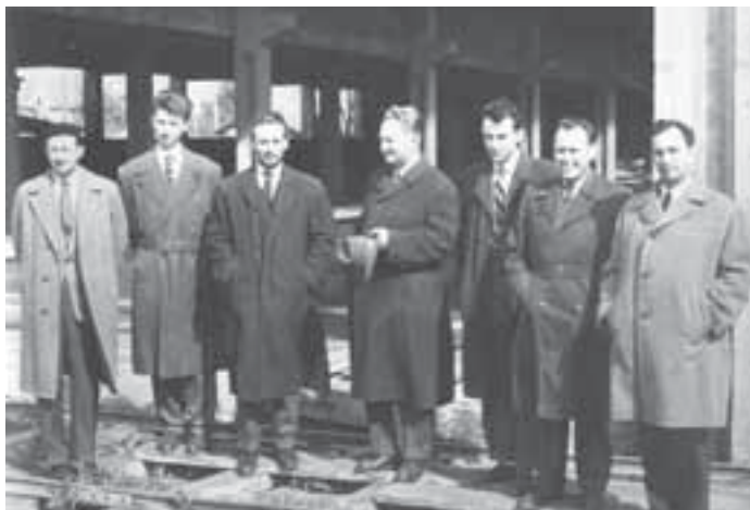
Pri rozostavanej budove Chirany na Vrbovskej ceste v Piešťanoch v roku 1959 stoja: (zľava) Friedrich Smolka, Štefan Kočvara, Emil Šupa, Slavomír Chorvát, hlavný energetik (meno nepoznáme), Otto Hrdina a Bohuslav Kriško.
